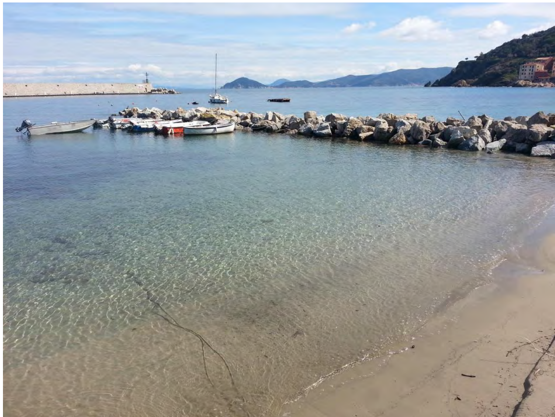
Figura 6. Spiaggia all'interno del pennello via Murzi
